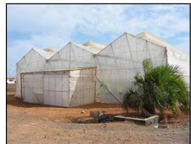
Doble puerta en invernadero
